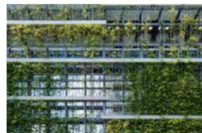
Eksempel grøn facade ved Parkeringshus.
